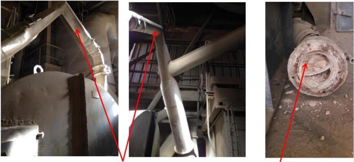
La figure présente le dépoussiérage de la tête élévateur d'une gaine d'un diamètre de 180 mm, cette gaine est bouchée de temps à l'autre à cause de la matière humide et collante. L'humidité provient de la chaleur clinker mélangé à l'humidité du calcaire et gypse.
