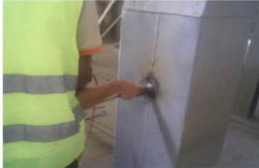
Figure 13 : Réalisation du piquage a la sortie de ventilateur
