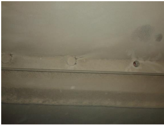
Figure 30: Cisaillement des boulons
