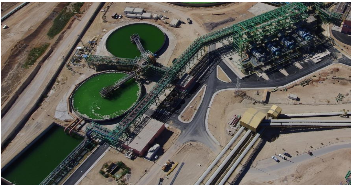
Figure 20 :L'installation de l'adaptation
