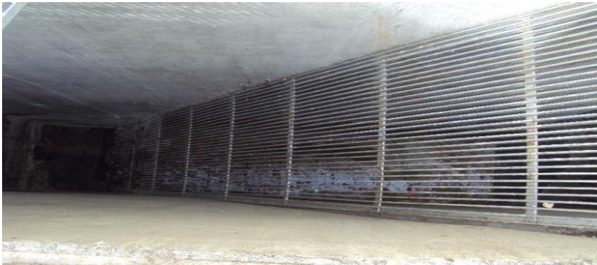
Annexe 7 : Tamis fin de la STEP de la CBGN
