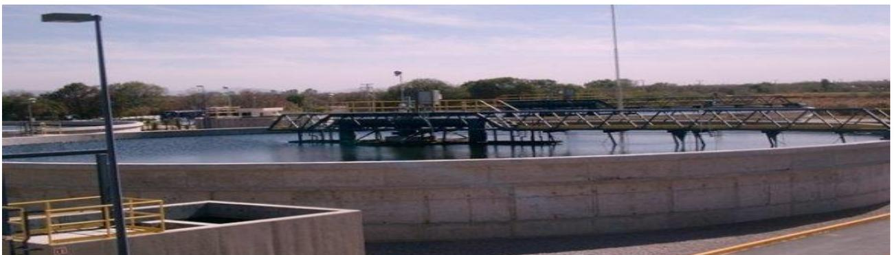
Figure 7 : Photo d'un Clarificateur (décantation secondaire)
