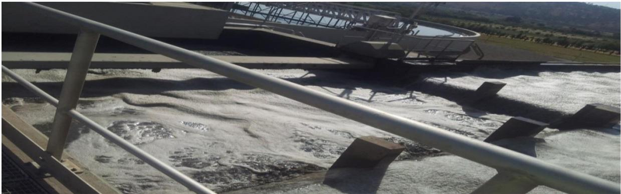
Figure 6 : Photo d'un dégazeur de la STEP Fès
