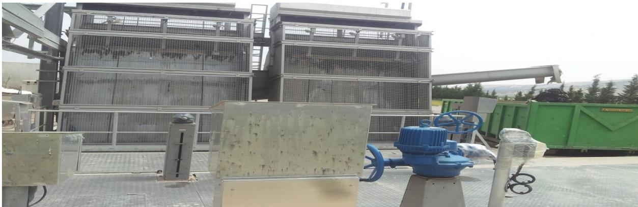
[Figure 2 : Photo d'un dégrillage grossier](#)
