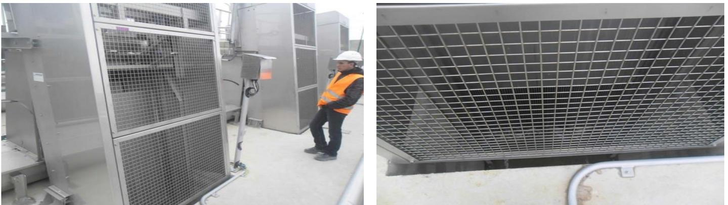
Figure 3 : Photos d'un dégrillage Fin
