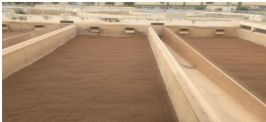
Figure 6 : filtre à sable
