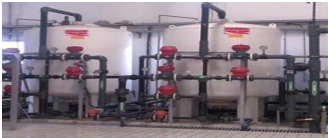
Photo 2 : Décarbonateur
