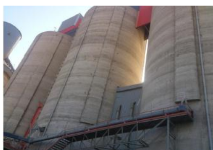
Figure 10 : Silos à ciment
