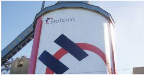
Figure 8 : Silo à clinker
