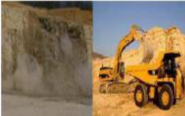
Figure 3 : Carrière Calcaire RAS EL Maa
