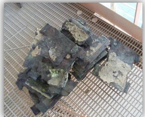
Fig.27 : Chute des plaques des cyclones
