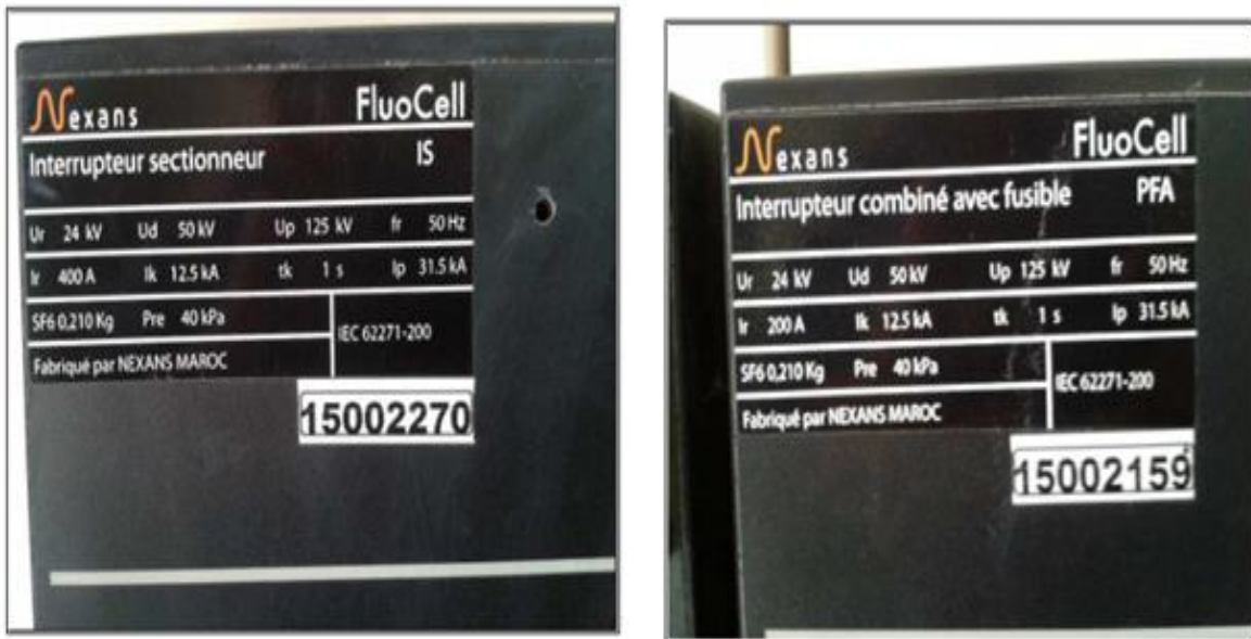
Figure 2: Exemple des plaques signalétiques des cellules
