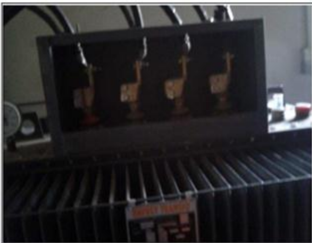
Figure 5: Transformateur MT/BT
