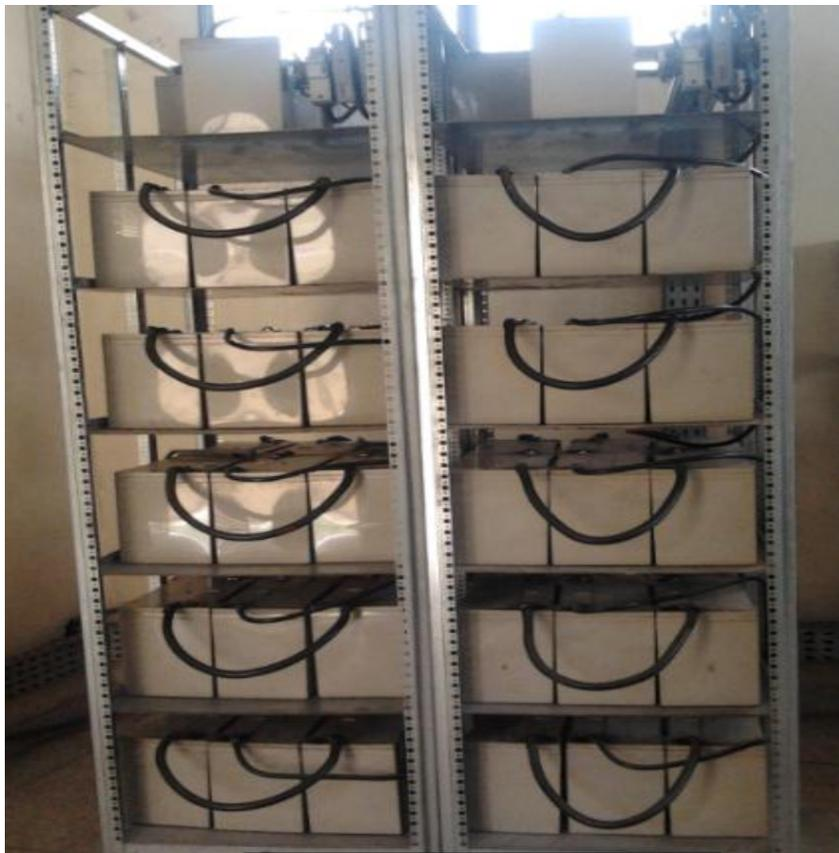
**Figure 1:** photo des batteries d'accumulateurs.
