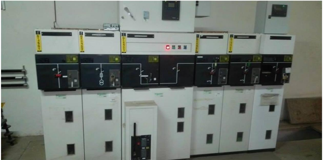
**Figure 4: L'armoire du poste en cellules**
