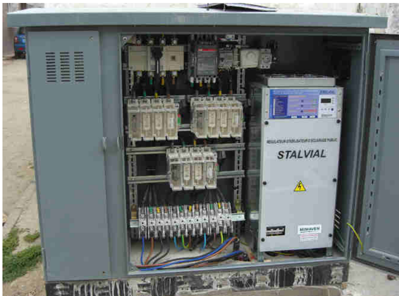
Figure 10 : Représentation d'un coffret d'éclairage public
