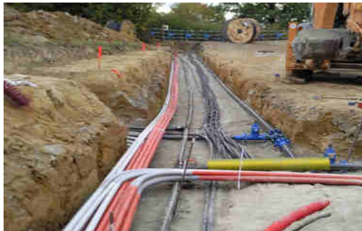
Figure 8 : Représentation d'un réseau souterrain
