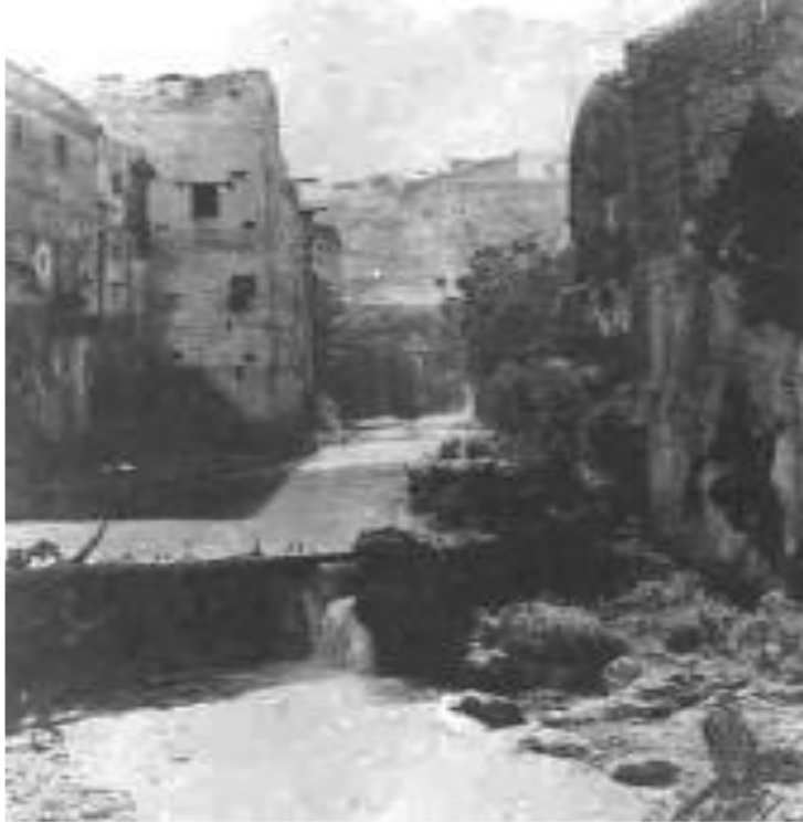
Figure 2: Inondation de septembre 1950 au niveau du quartier El Mellah
