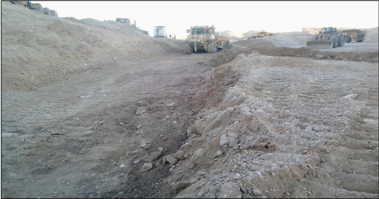
Photo 27 : Exemple d'un chargement contre déblai
