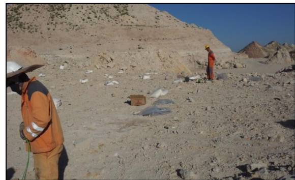
photo 7 : Remplissage des puits par l'Ammonix
