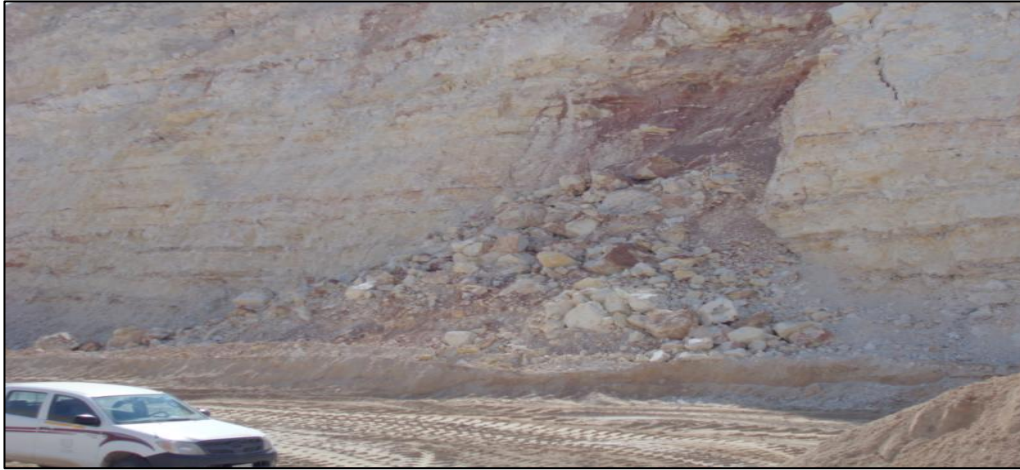
Photo 23 : Exemple d'un mauvais dressage du parement
