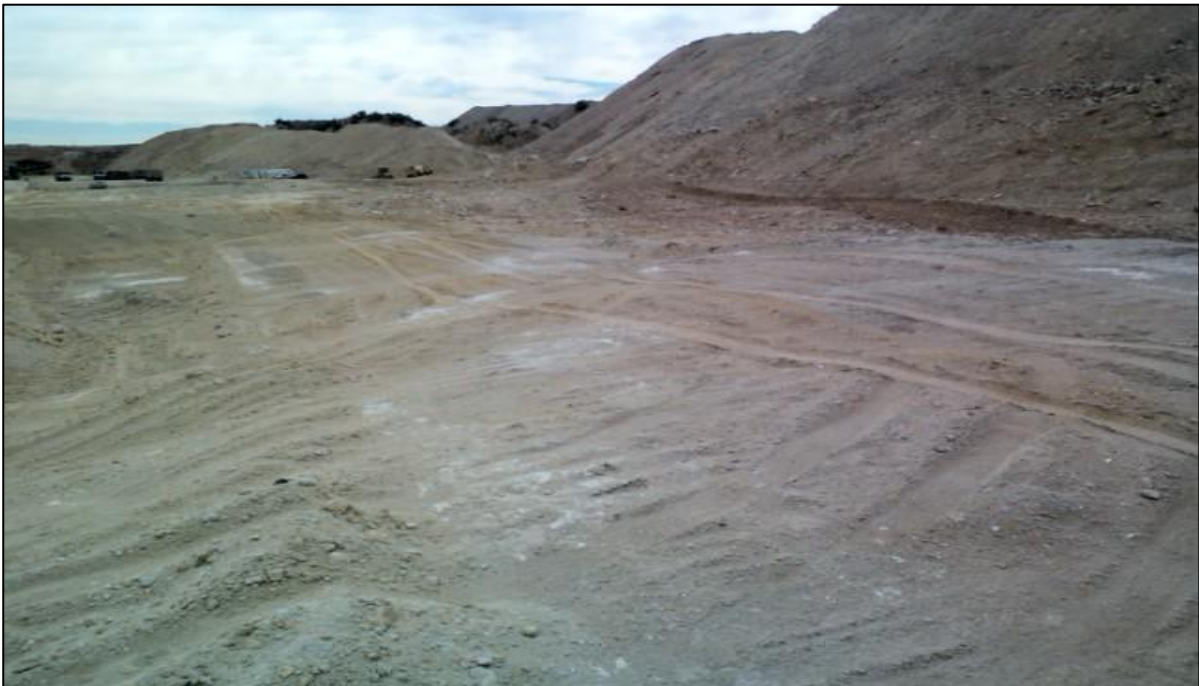
Photo 28 : Réalisation d'une tranchée avec une fausse berme
