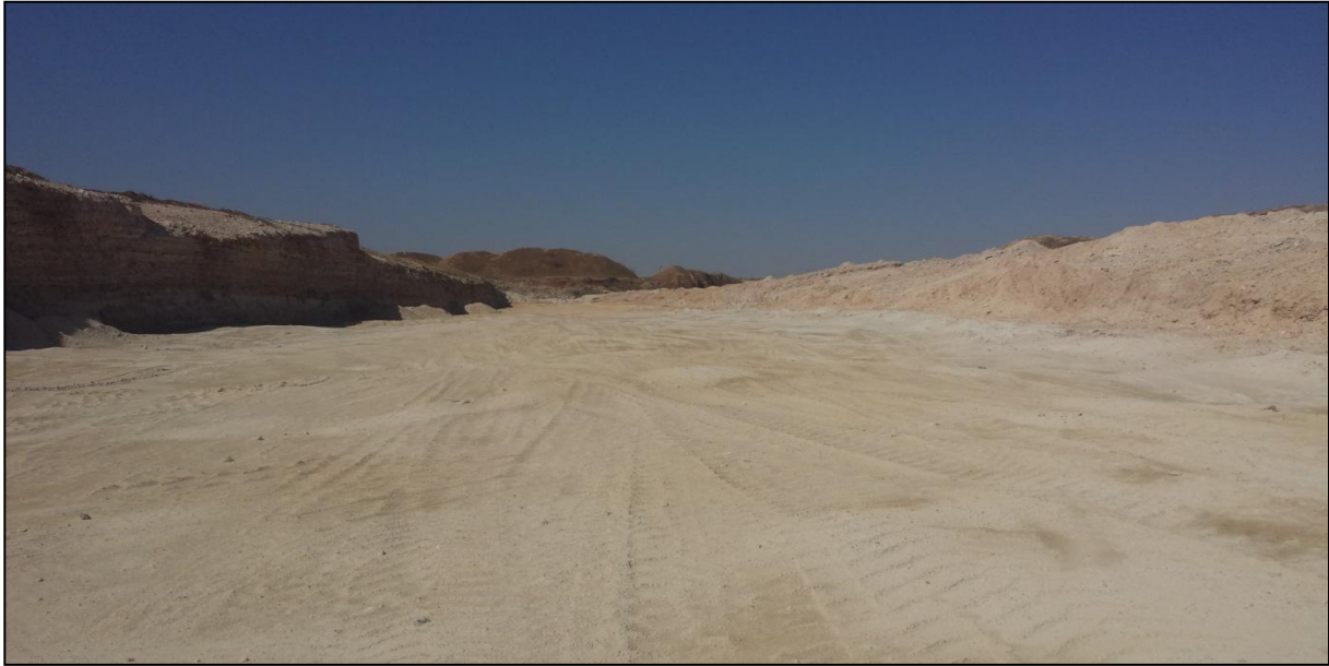
Photo 33 : Exemple des affaissements paraboliques au niveau de la R7
