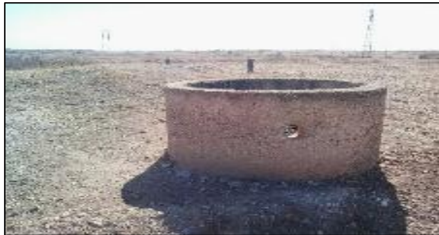
Photo 1 : Exemple d'un puit de reconnaissance
