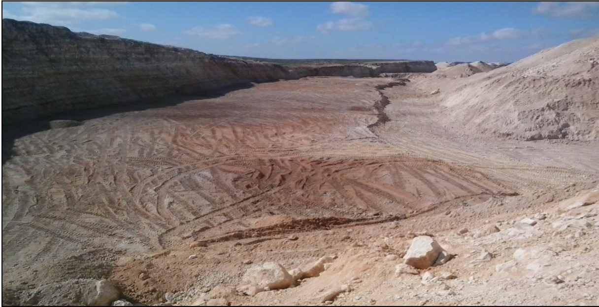
Photo 29 : Réalisation d'une berme par casement
