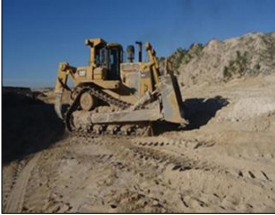
Photo 8 : D9R pendant le décapage
