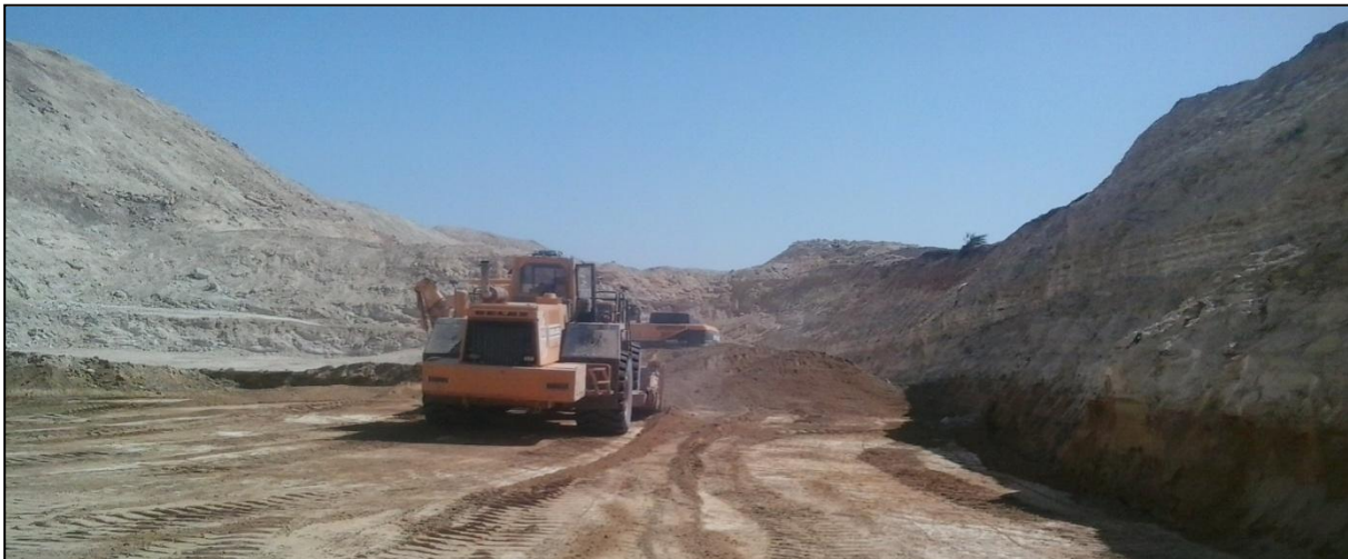
Photo 34: Nettoyage de la partie basale assuré par un paydozer
