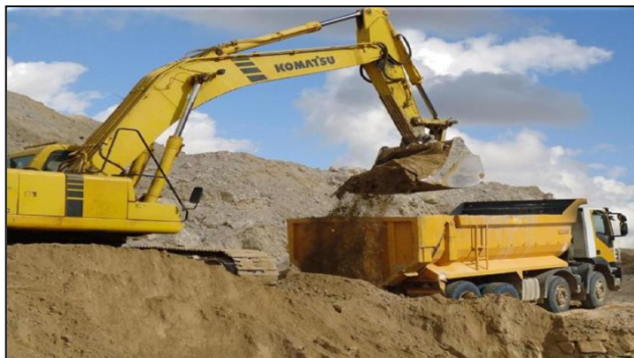
Photo 14 : Transport du stérile par un camion 170T
