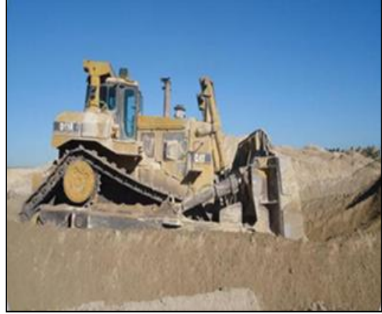
Photo 9 : D11R pendant le décapage
