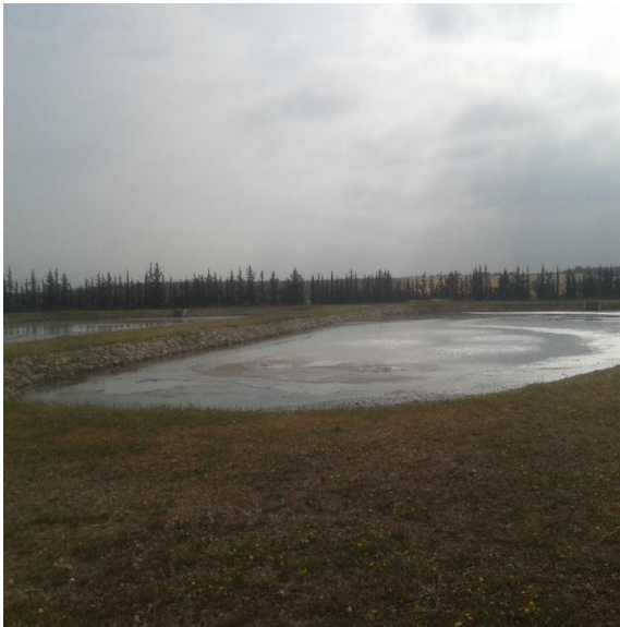
Image 7 : Bassin de traitement primaire
