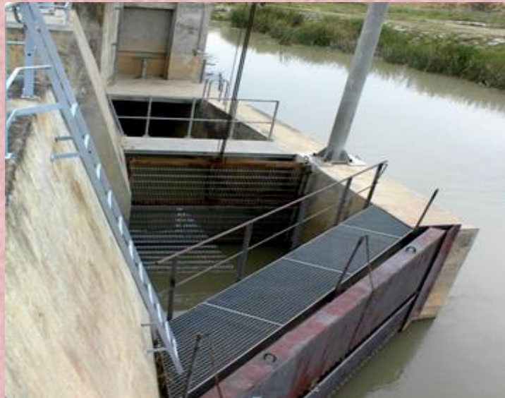
Figure 3 : le dégrilleur
