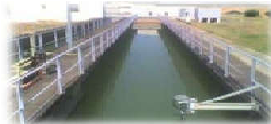
Figure 3: Opération de dessablage
