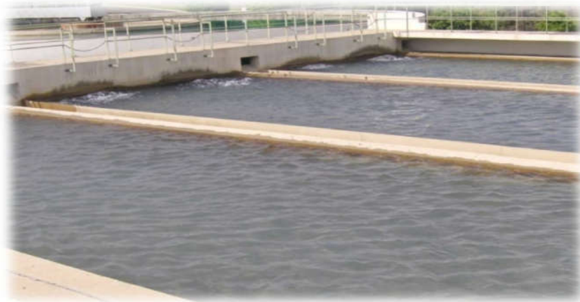
Figure 7: Filtre à sable
