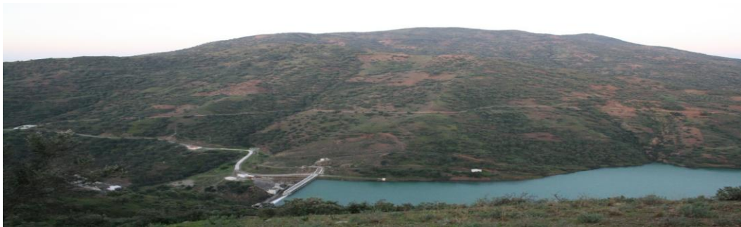
Image 1 : photo de Barrage SAHLA
