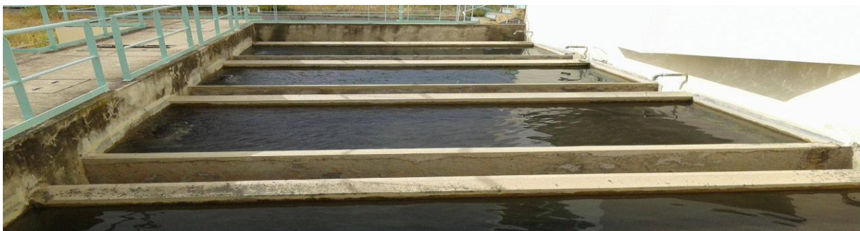
Image 7 : les bassins de la filtration par le sable
