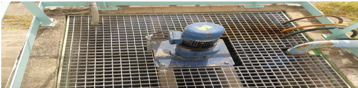
Image 5 : Le système permettant l'ajout de coagulant
