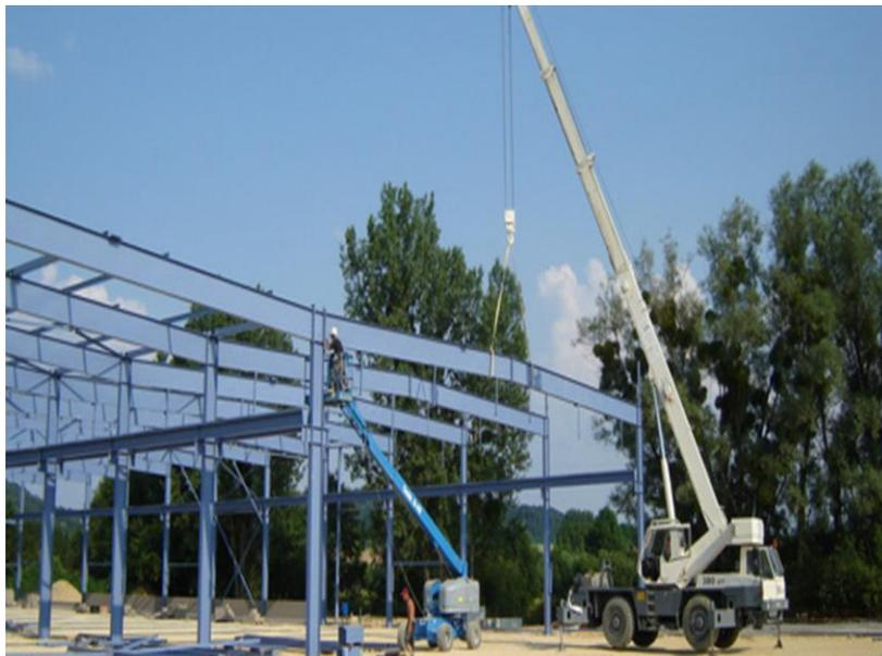
Figure 5 : exemple des grues utilisé pour le montage
