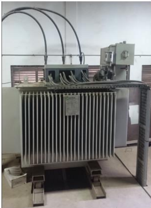
Figure 10 : Caractéristiques du Transformateur 630 KVA
