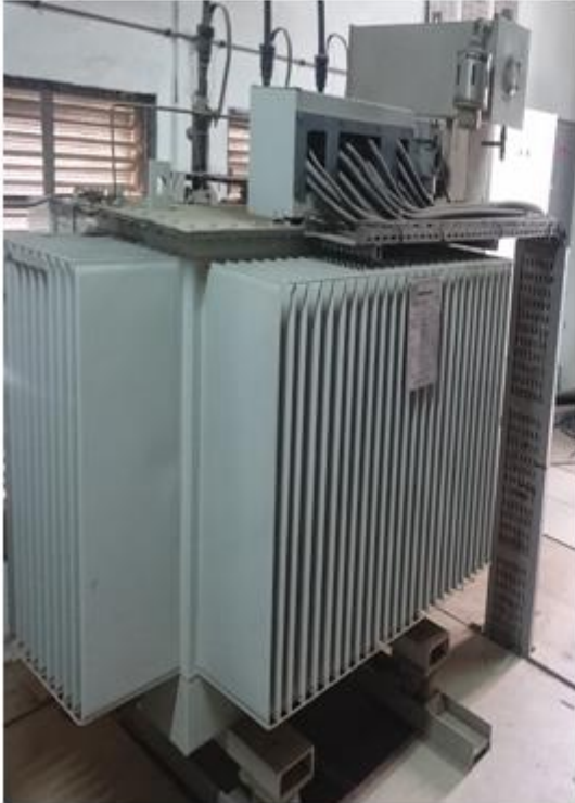
Figure 11 : Caractéristiques du Transformateur 1000 KVA
