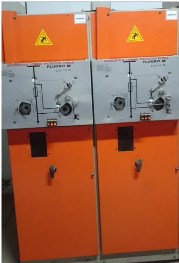
Figure 12 :Description de cellule de protection des deux Transformateurs 1000 KVA/630KVA
