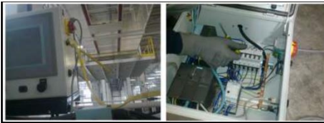
Figure 43 : Installation des macs
