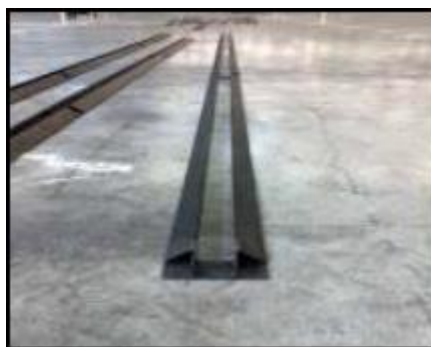
Figure 45 : Fixation des rails
