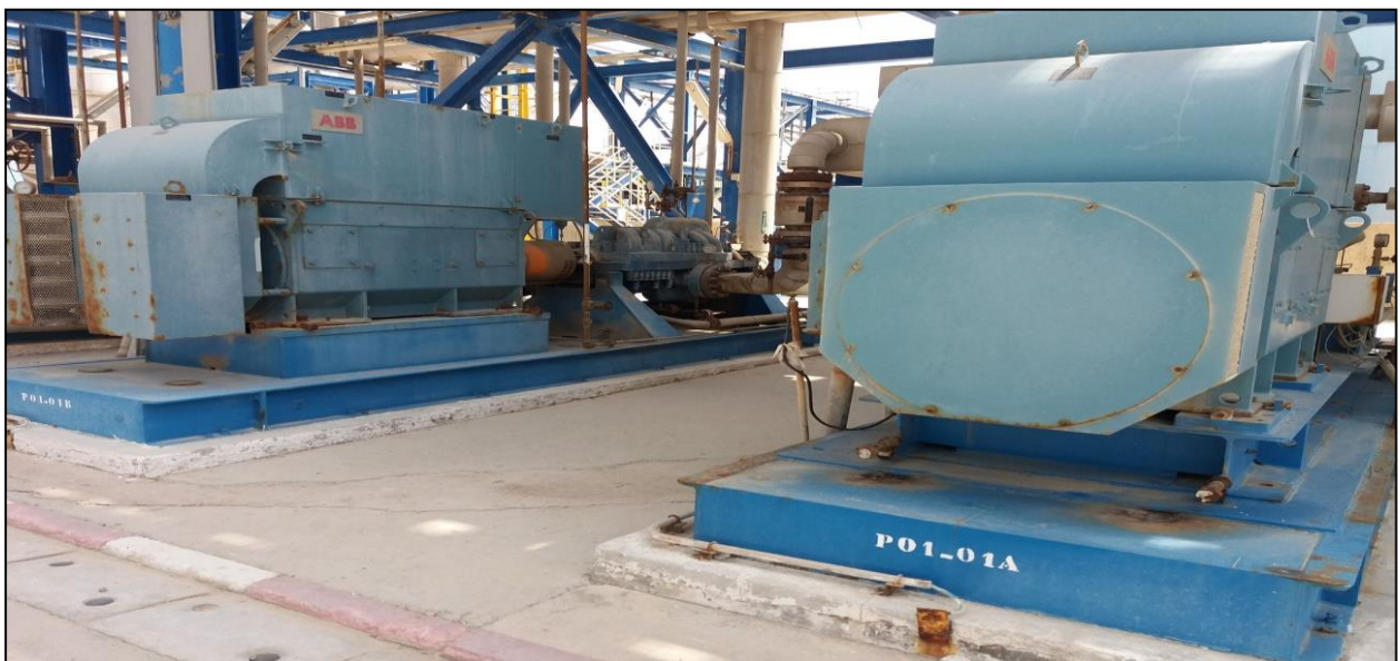
Figure 11 : Les deux groupes électropompes d'eau alimentaire HP P-01-01A et P-01-01B de la ligne H.
