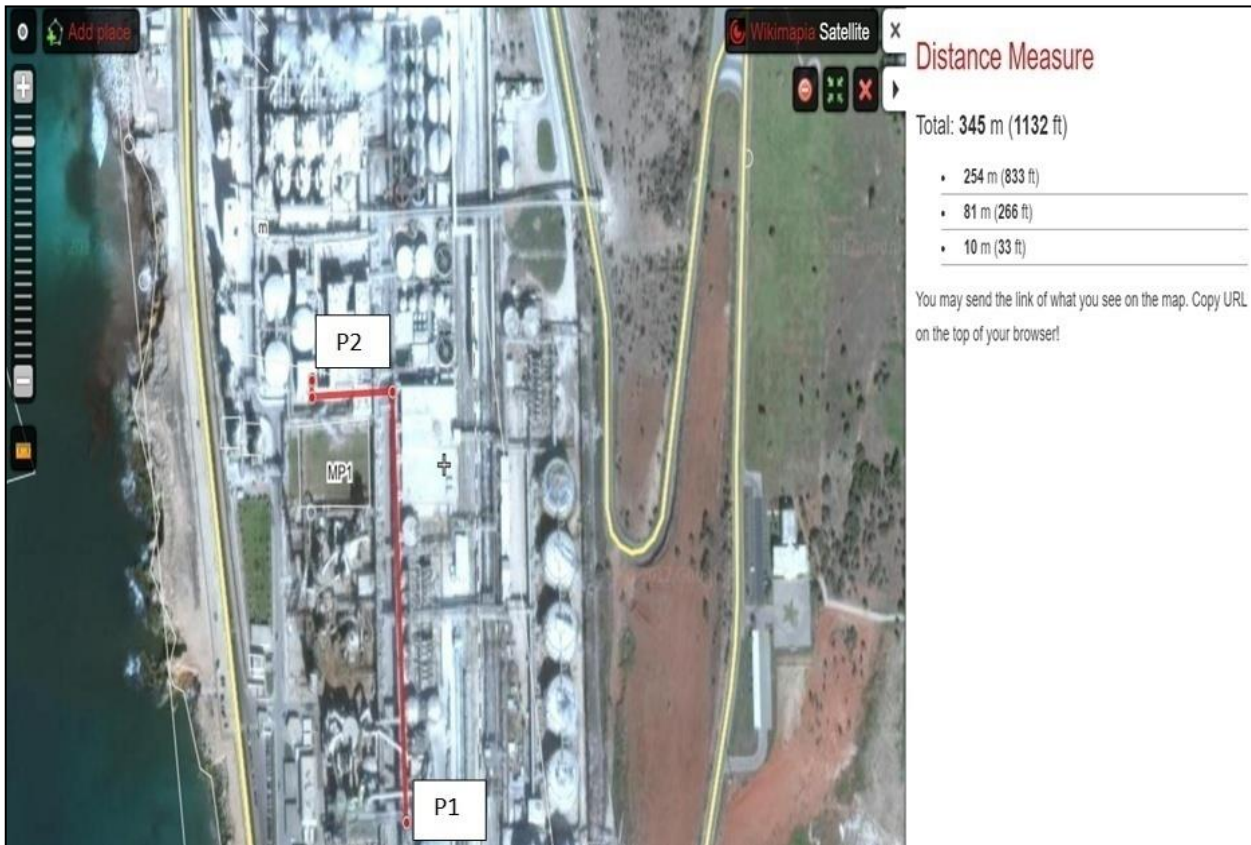
Figure 23 : Chemin de câble de puissance du moteur & Distance approximative entre le moteur de la pompe P-01-01C et son disjoncteur à la centrale de MP1.
