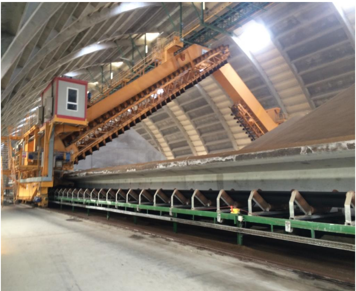
Figure 8: Vue sur le gratteur du hangar HE5
