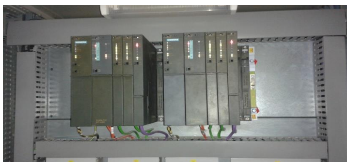
Figure I-2.6 Deux CPU redondantes du S7 400H.
