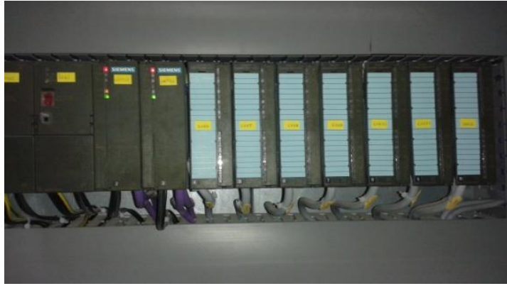
Figure I-2.7 Station de périphérie décentralisée ET200M
