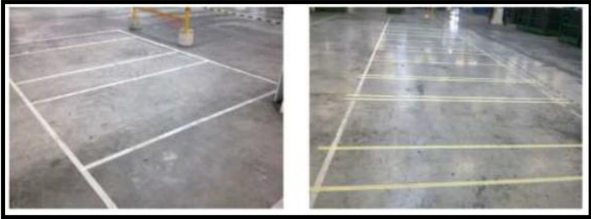
Figure 40 : Traçage intérieur de la zone
