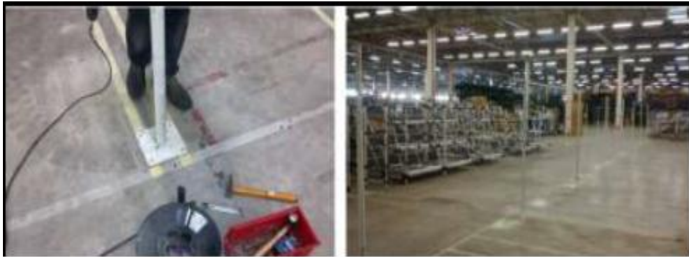
Figure 42 : Installation des mats
