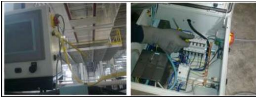
Figure 45 : Installation des macs
