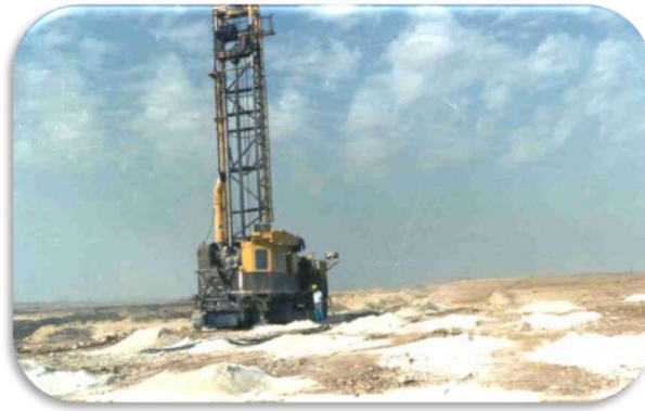
Figure 3 : Opération de foration par une sondeuse
