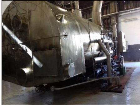
Figure 7: Chaudière de capacité 13 bar
