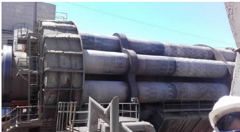
Figure 8 : Refroidissement à ballonnets
