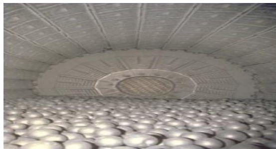
Figure 5 : Une vue de l'intérieur du broyeur à cru
