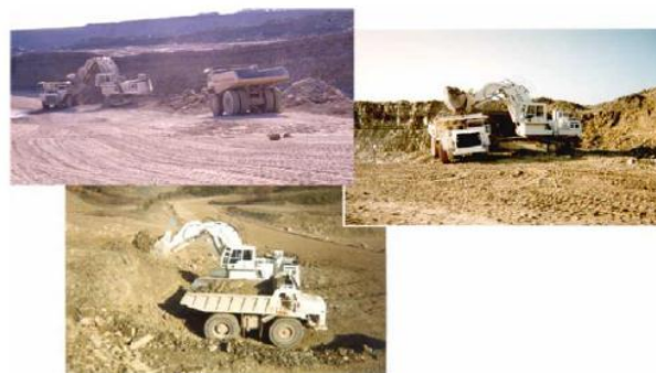
Figure 4 : Les carrières argile et calcaire
