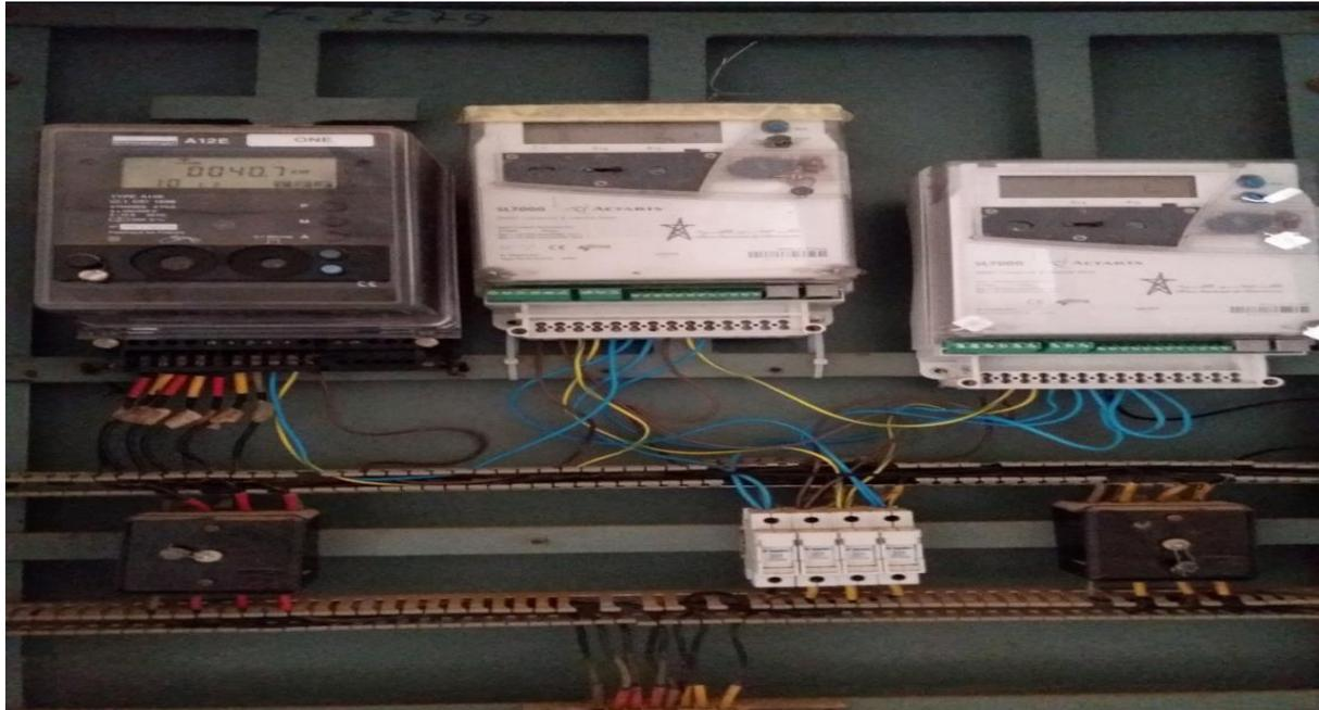
Figure III.1 : Mise en parallèle de trois compteurs numériques
