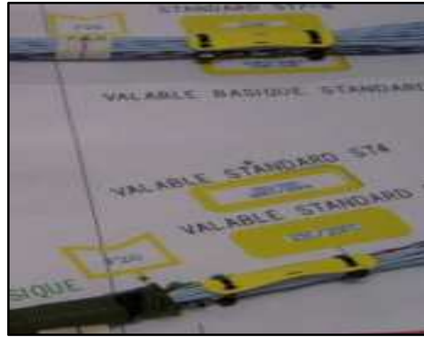
Figure 18: Montage des plaquettes repères.
