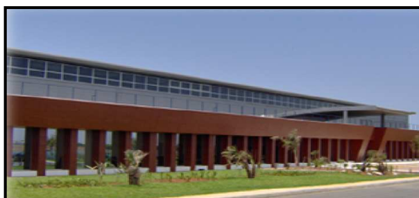
Figure 3: La nouvelle usine Labinal Maroc à AIN ATIG.
