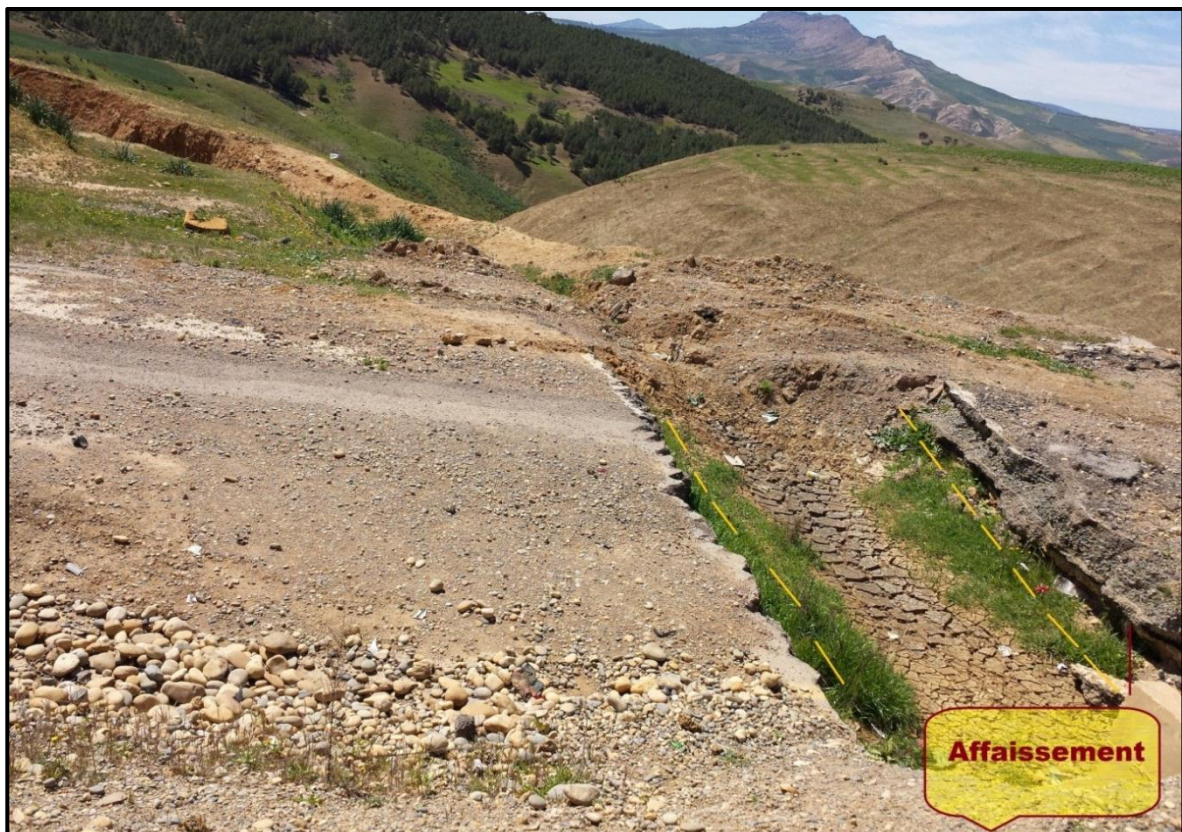
Figure I.2 : État du Tronçon d'étude.
