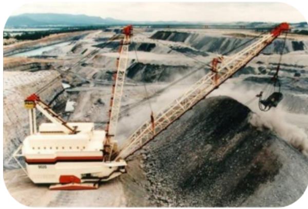
(b) décapage par dragline
