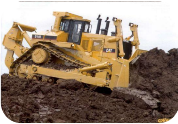
(a) décapage par D11
