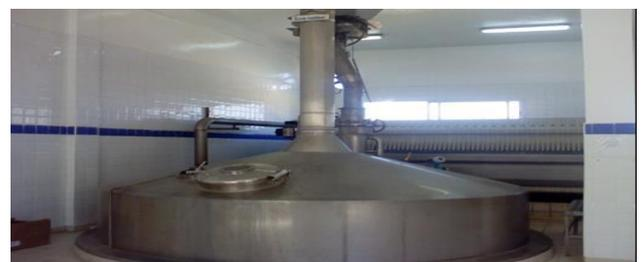
**Figure 7 : Cuve matière à SBM Fès**
