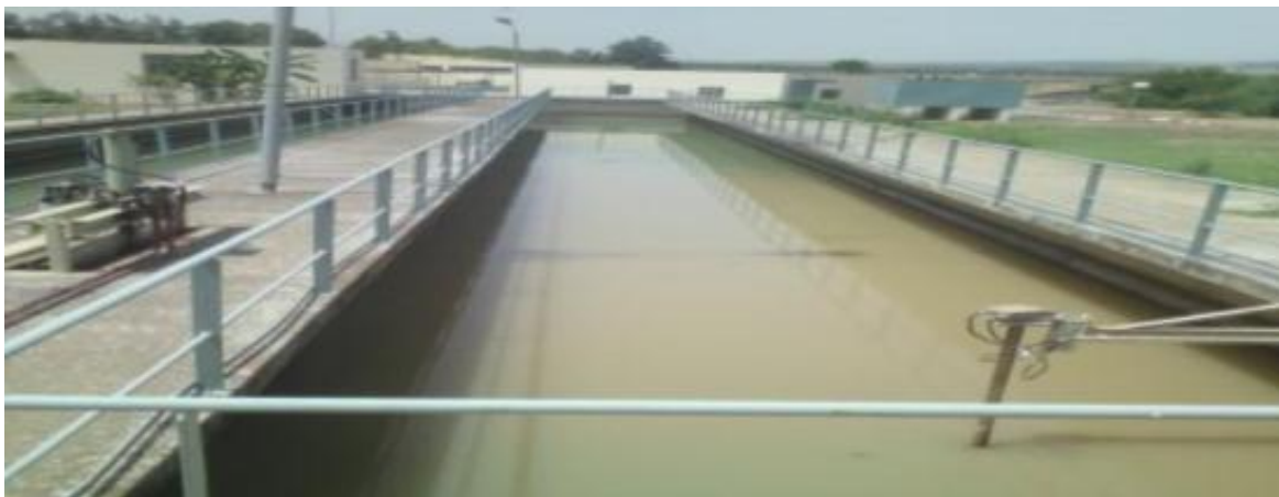
Figure 4: opération de dessablage
