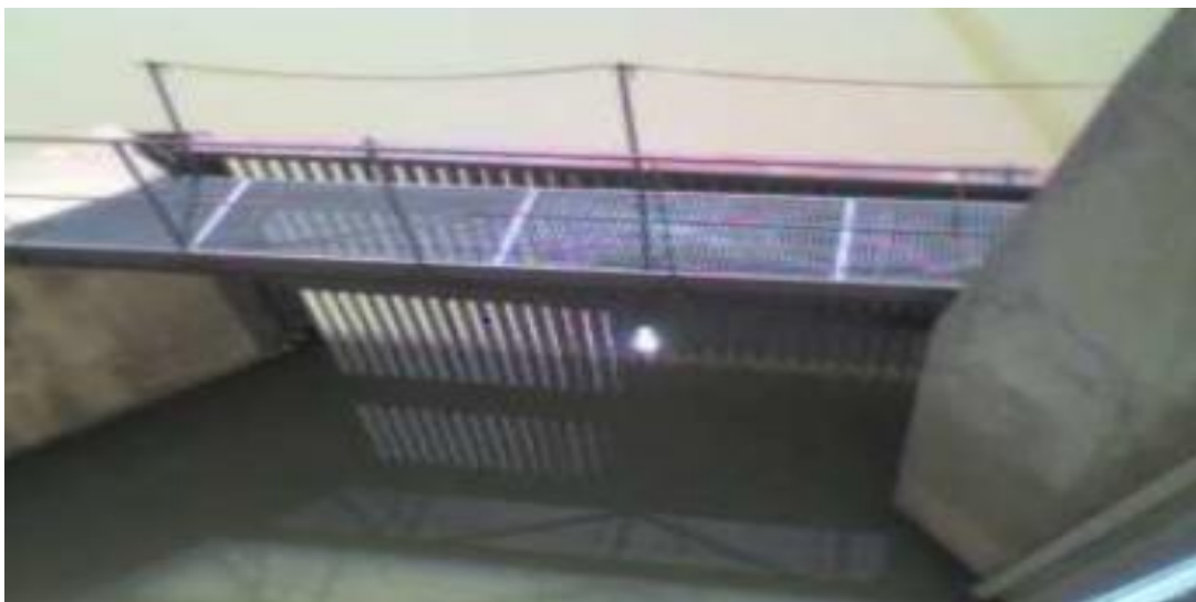
Figure 2 : opération de dégrillage
