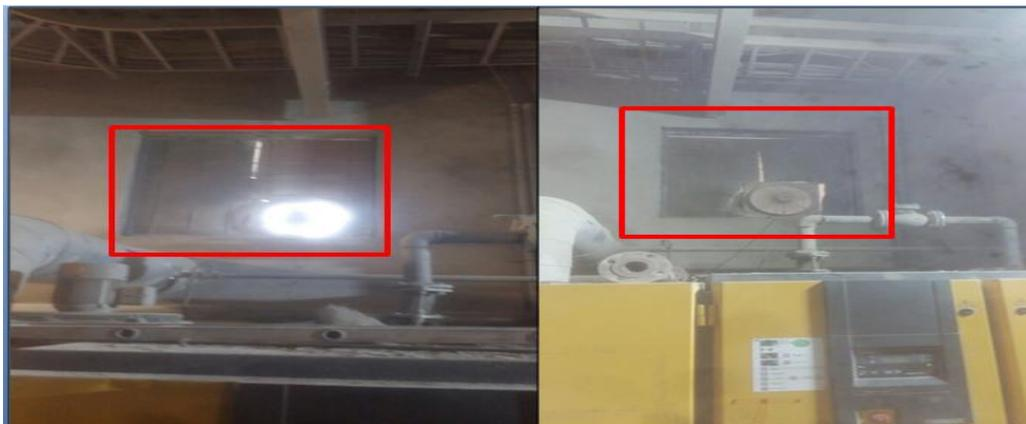
*Figure 14 : ventilateurs sous dimensionnés*
