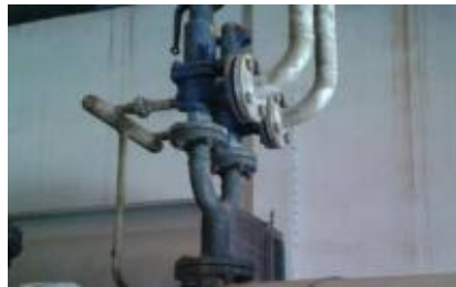
Figure 18 : Soupape de sûreté
