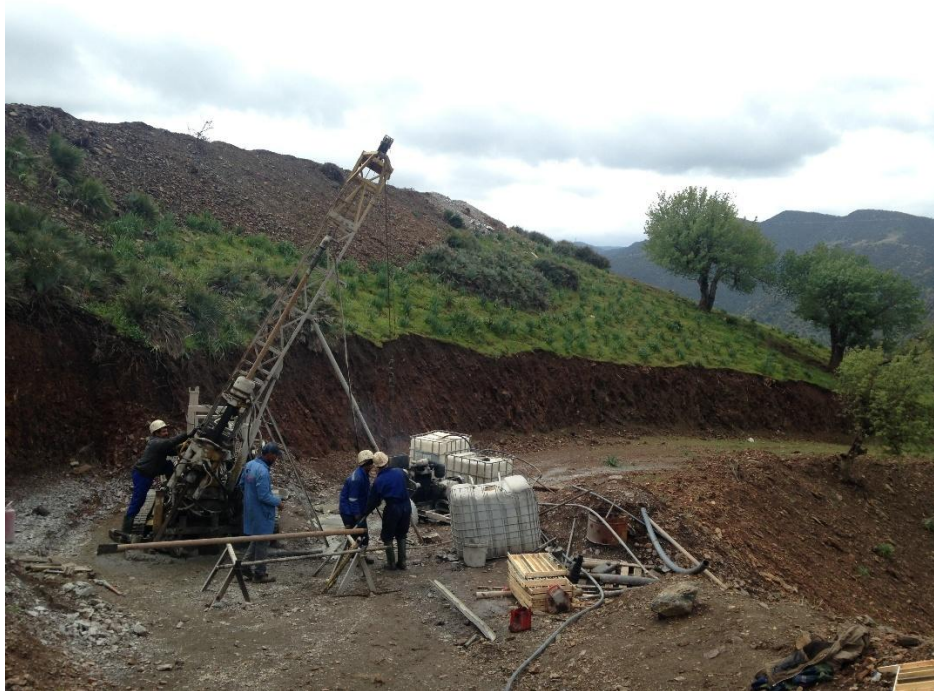
Figure 34 : sondeuse LY 38 au cours du sondage réalisé
