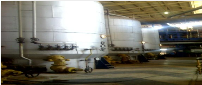
Figure 9: évaporateur à multiples effets
