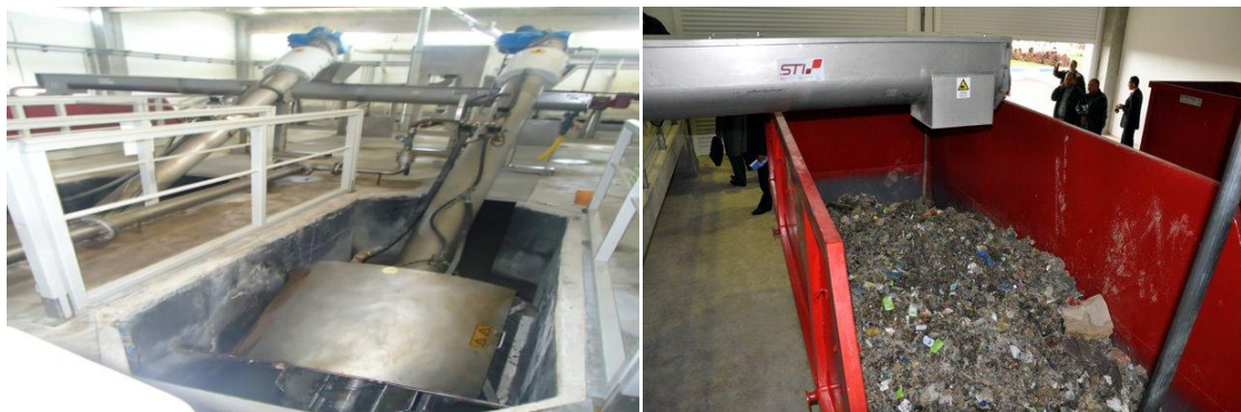
Figure 4: Degrilleur auto et refus de dégrillage
