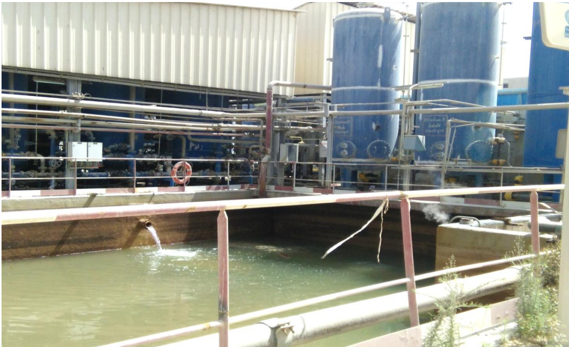
Figure 10: Bassin de récupération des eaux résiduelles (Maroc Phosphore D).
