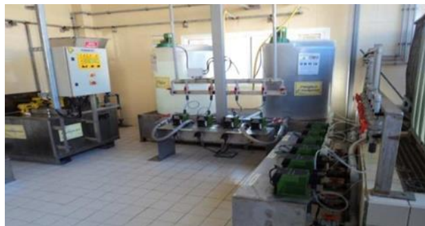
Figure 14: station d'ajustement des produits d'addition
