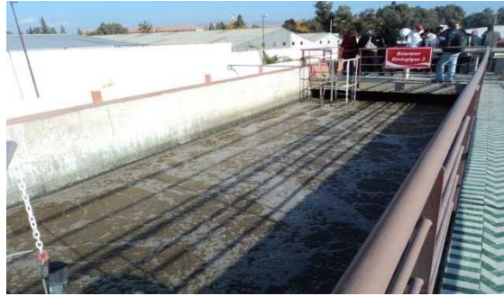
Figure 6: réacteur biologique de la STEP de la CBGN
