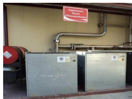
Figure 4 : bassin d'homogénéisation (à gauche) et (à droite) les supprimeurs du bassin d'homogénéisation
