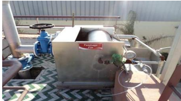
Figure 3: tamis fin de la STEP de la CBGN
