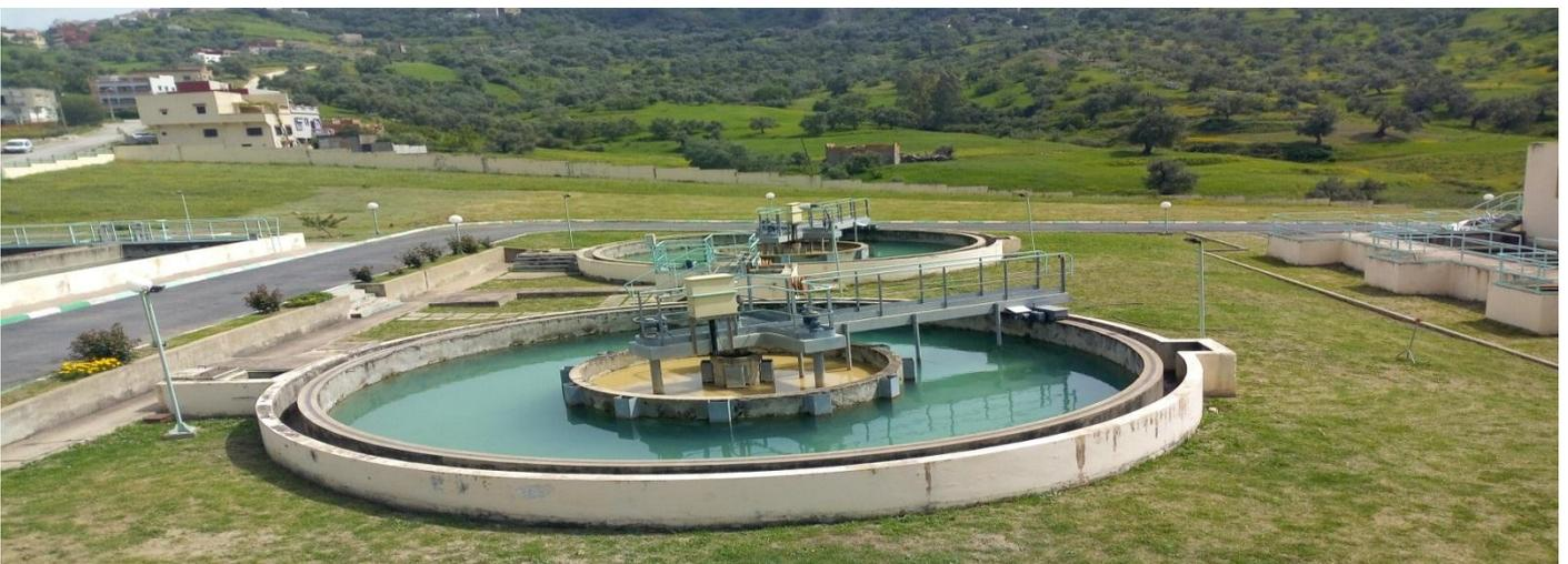
Figure 3 : décanteur
