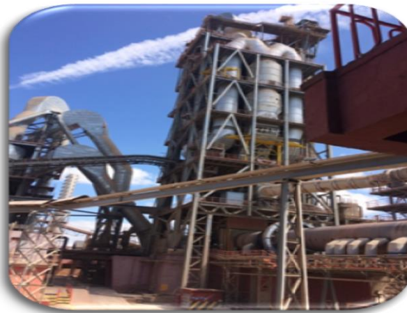
Figure 5: Tour de préchauffage.
