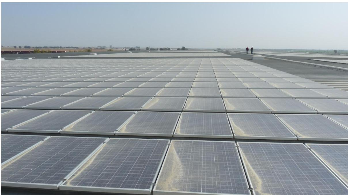
**Figure 6 :** Accumulation de la poussière sur des panneaux PV
