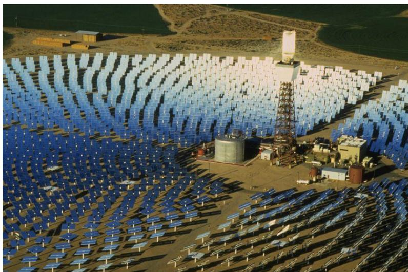
**Figure 2 :** Centrale solaire thermodynamique à tour
