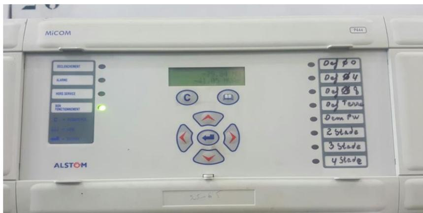
**Figure 2.2 : Micom P444 Alstom**
