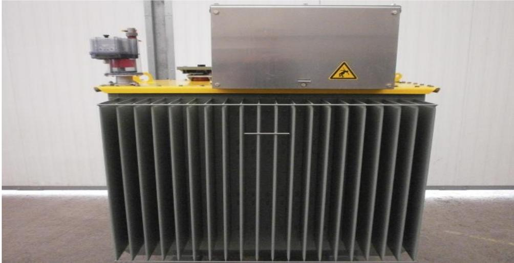
**FIGURE 11 : Un transformateur de puissance 630KVA.**
