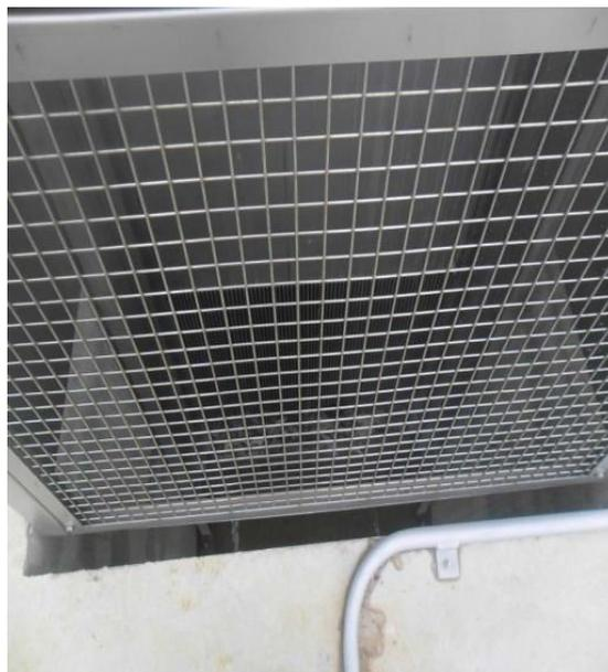
Figure 10 :Photo d'un dégrillage grossier
