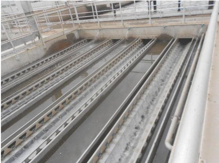
Figure 13 : Bassin de décantation primaire (système laminaire) STEP Fès
