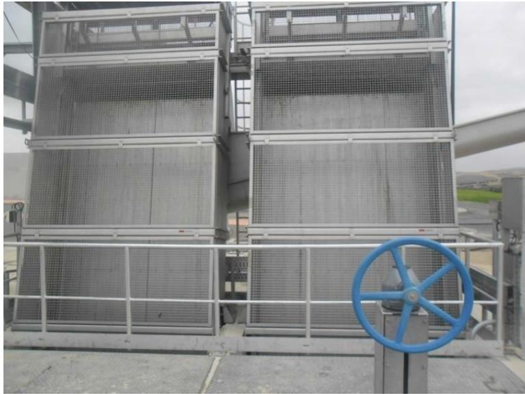
Figure 11 :Photo d'un dégrillage fin
