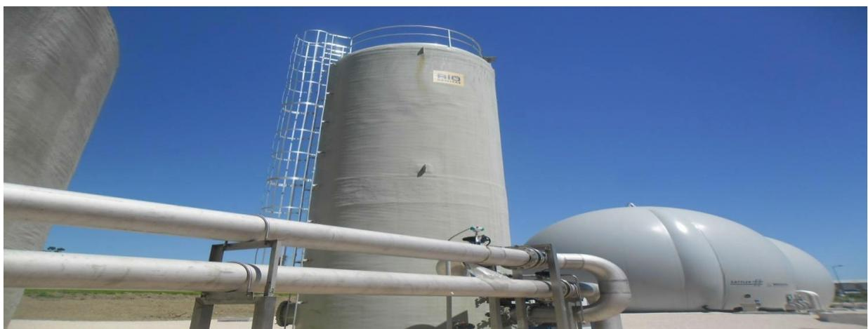
Figure 19 : Photo d'un désulfure de biogaz
