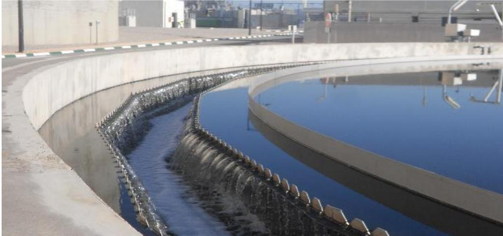
Figure 15 :Photo d'un clarificateur
