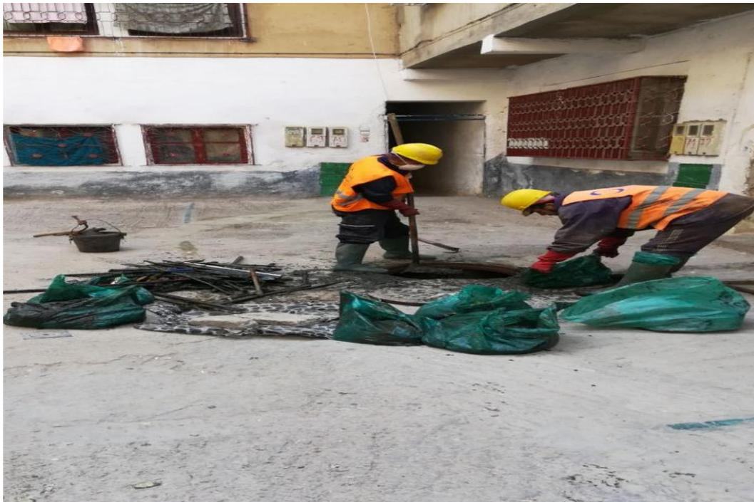
Figure 7 :Curage manuel des ouvrages annexes par tringlette
