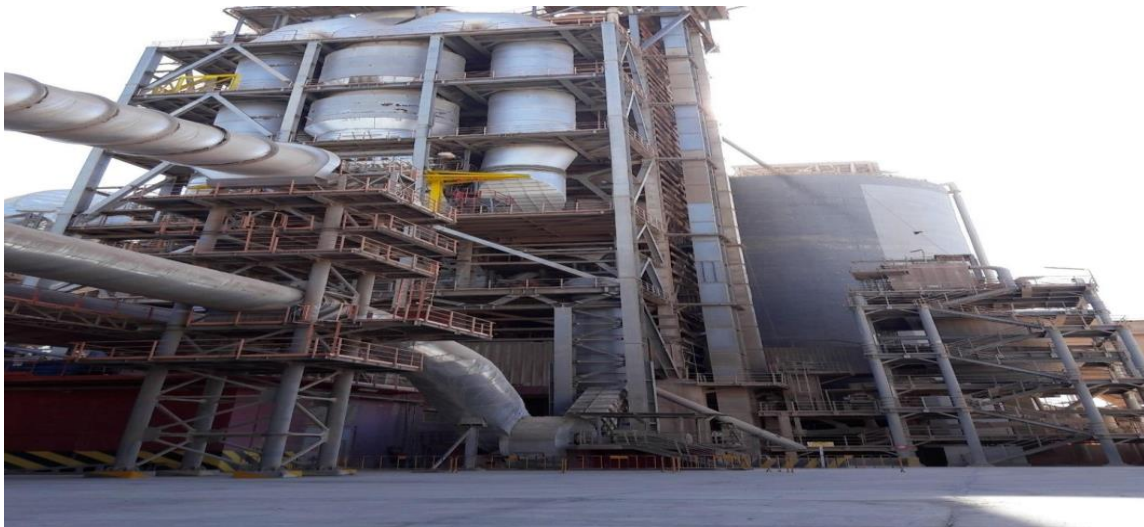
Figure 4 : tour de préchauffage de l'atelier de cuisson
