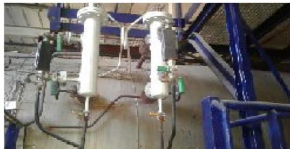
**Figure 13: Pressostat de régulation**
